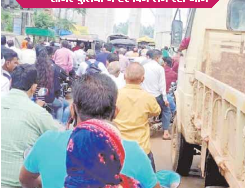
मिशन चौक ओवर ब्रिज का निर्माण कार्य पूर्ण नहीं होने का खामियाजा पूरे शहर को भोगना पड़ रहा है। सागर पुलिया में हर दिन जाम लगने की वजह से हजारों लोगों को कई तरह की परेशानियों का सामना करना पड़ रहा है। कल शुक्रवार की दोपहर सागर पुलिया के नीचे जाम लगने की वजह से करीब एक घंटे तक लोग परेशान रहे।
