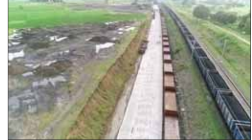
निकले अनुपयोगी मोनो ब्लाक कोंक्रीट स्लीपर का उपयोग किया गया है, जिससे ब्लैक डस्ट की सहायता से उचित फोर्लिंग कर लगाया गया है, इससे सरफेस समतल और मजबूत हुआ है। * समतलीकरण कार्य की लंबाई 647 मीटर है और चौड़ाई 10 मीटर है। पूर्व में बरसात के समय में कोयले की लोडिंग एवं अनलोडिंग में मुश्किल हुआ करती थी मगर अब इस समतलीकरण से माल का लदान-उतरान सुविधाजनक तरीकों से हो सकेगा। इस साइडिंग में उचित संघनन के साथ मिट्टी को ठीक कर सतह का समतलीकरण किया गया है। साइडिंग में डब्ल्यूबीएम का कार्य नंबर 2 का उन्नयन किया गया है, जिससे कोयला
