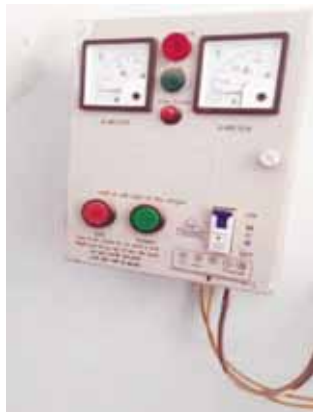
उपभोक्ता के घर में लगा सबमर्सिबल पंप, जो लो वोल्टेज की वजह से स्टार्ट नहीं हो रहा।
